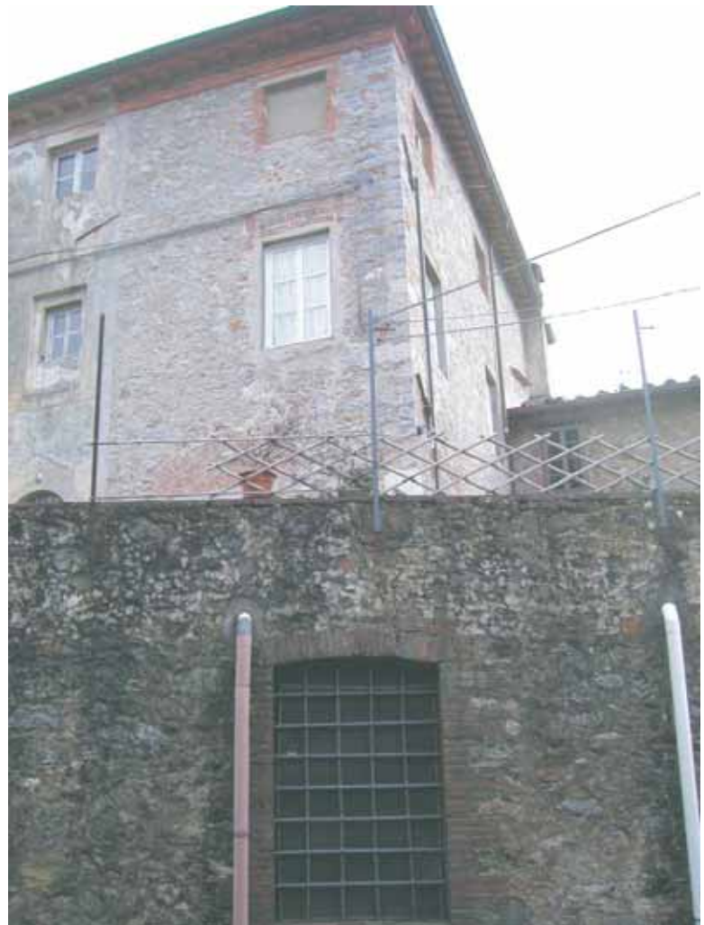
Terasse og inngang til cantina (kjelleretg.)
